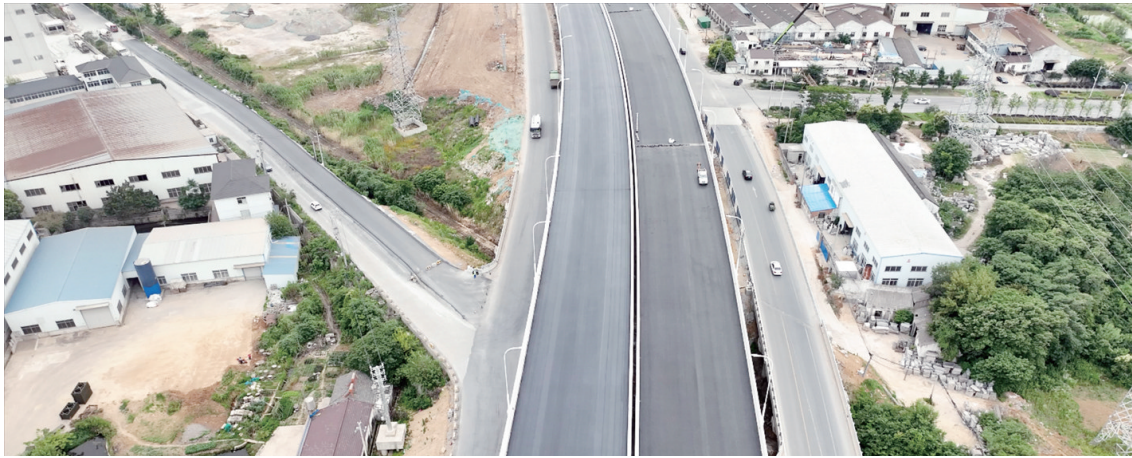
镇江312国道城区段1标建设者全力推进工程进度。 朱茜 摄
