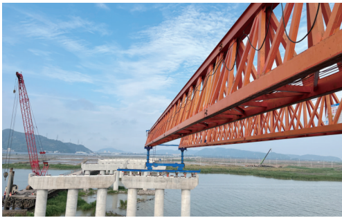
在漩门湾七桥施工现场，架桥机准备就绪。 顾坚 摄
