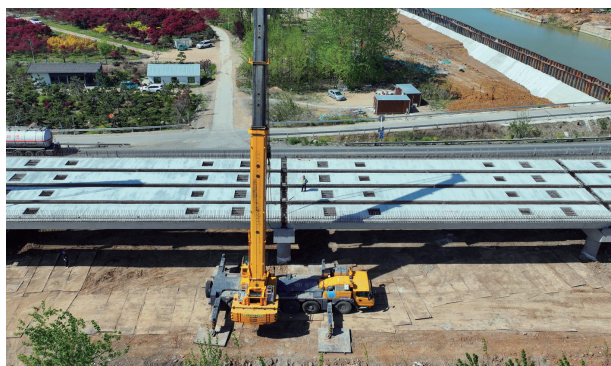
在205国道跨航道桥施工现场,两台大型吊车正在进行30米预应力混凝土小箱梁吊装、架设作业。丁华明 摄 视觉江苏网供图
