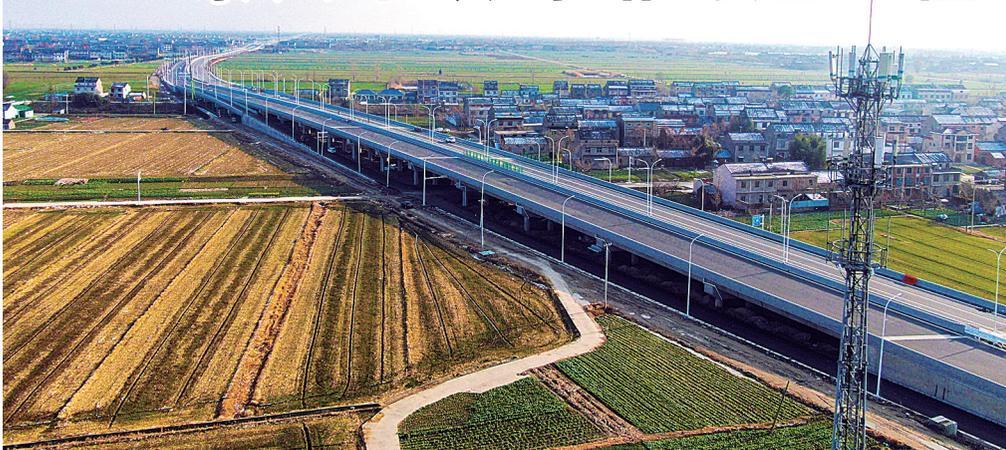
泰兴市镇海路南延工程路线全长约10.1千米,一级公路标准,设计速度80千米/小时。该工程先期实施334省道至308县道(珊七线)段,长约9.5千米,由集团承建,2022年5月开工,2023年12月通车。
